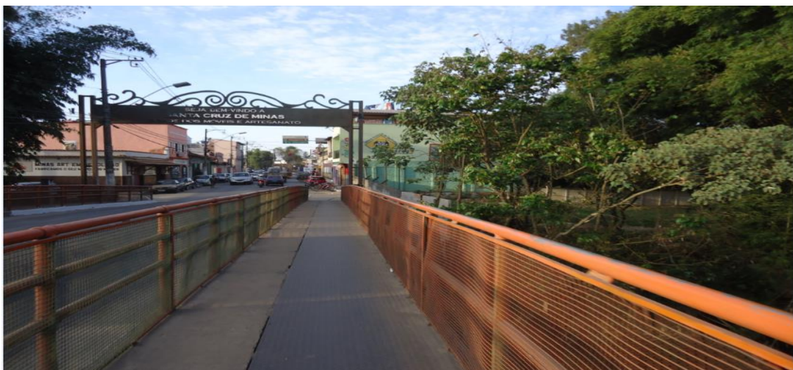
Figura 22: Ponte do "Porto" sobre o Rio das Mortes. Santa Cruz de Minas. FONTE: Acervo pessoal
